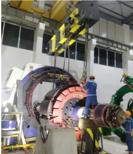
Đại tu rôto – kiểm tra stato máy phát
