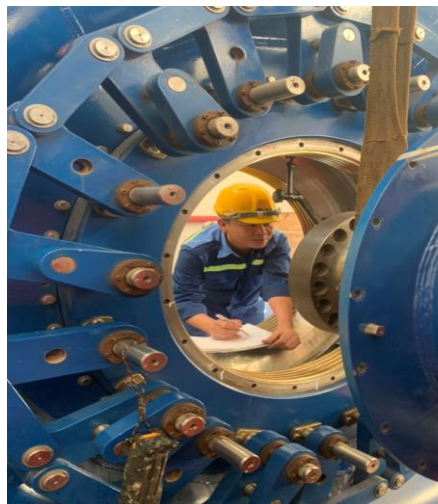
KS VCP M&E ghi nhật ký thi công
