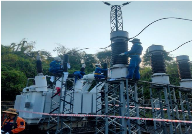
Bảo dưỡng máy biến áp lực ngoài trời
