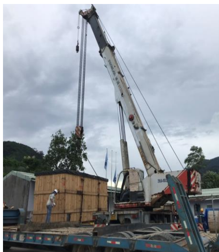
Bốc dỡ thiết bị tại công trường
