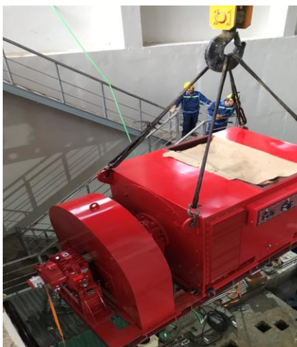
Cầu lắp máy phát (5MW) vào hầm máy
