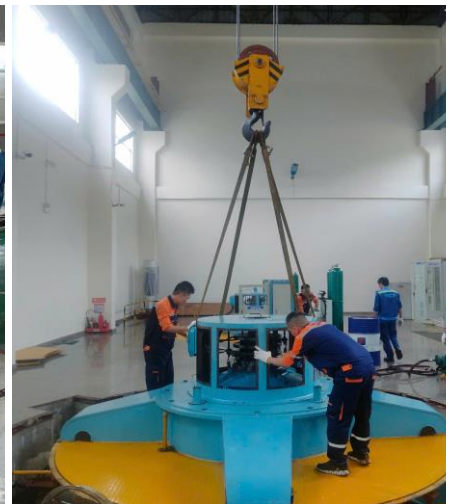
Lắp điều tốc tổ máy Kaplan trục đứng
